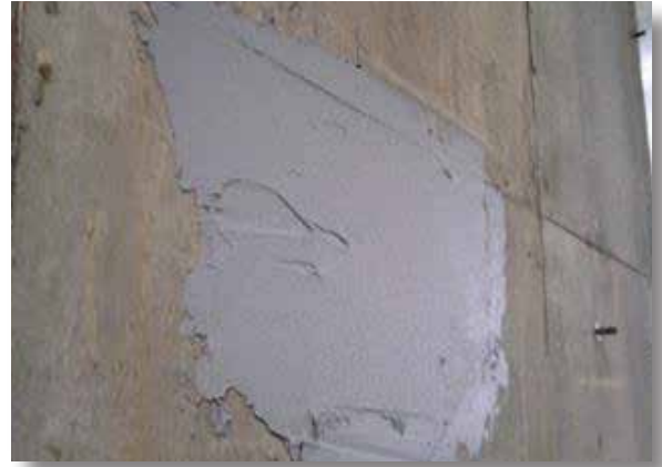
■型枠段差 ME ベース施工後
