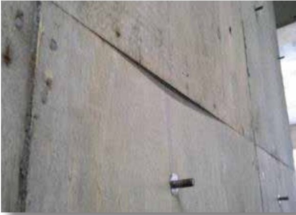
■型枠段差 施工前
