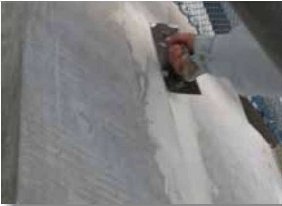
■目違い払い ME ベース施工中
