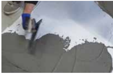
平ゴテでテラタイトグレーを塗布する
