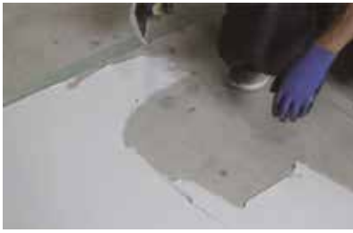
フレックスマルチを塗布する (3mmのくし目こてを使用後、平塗り)
