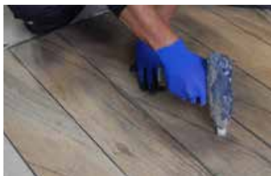
ビブラートを使用して密着する (レベルと目地合わせ)
